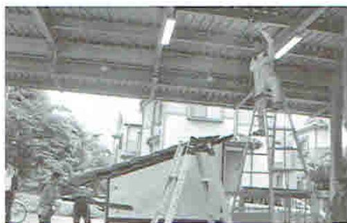
⑤雨を再現！ そんな実験台をまず製作！
