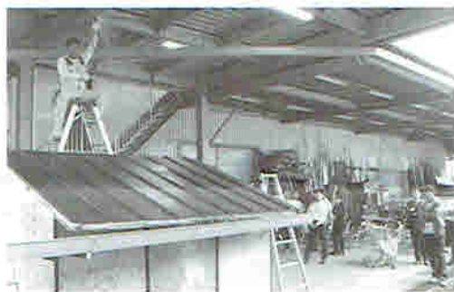
⑦さて！板金屋根の雨音は？
