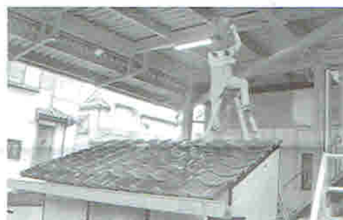
④まずは瓦屋根に雨を振らせて音を測定！
